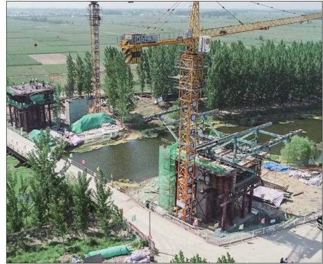
枣菏高速建设现场。
