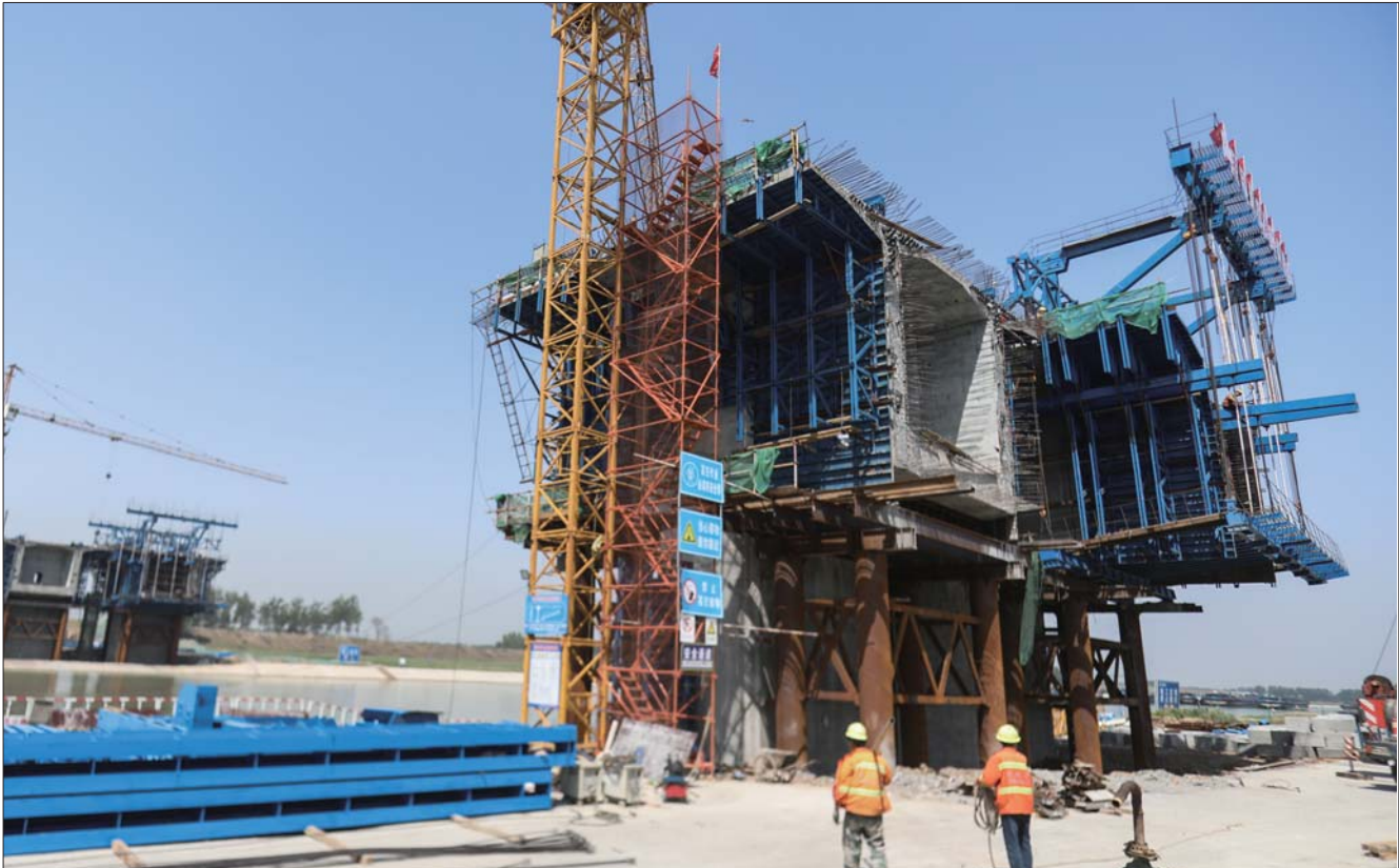
G105京澳线汶上任城界至唐口段改建工程京杭运河大桥施工现场。
