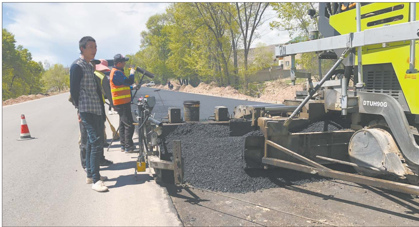
在吉尔吉斯斯坦伊塞克湖环湖公路项目上，工人正在施工。这条公路一期项目由山东企业承建。
