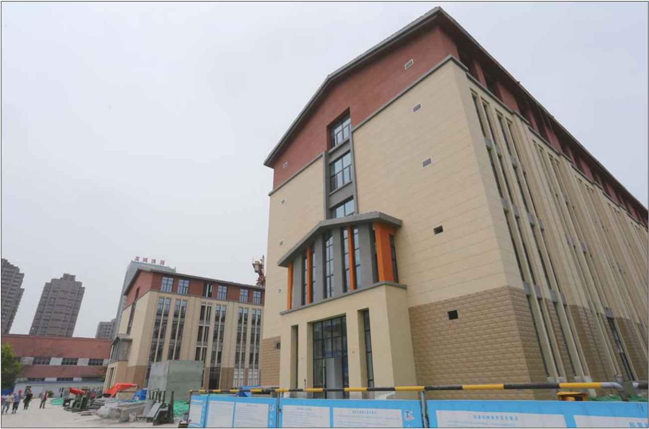
中心基地主楼主体已经完工。
