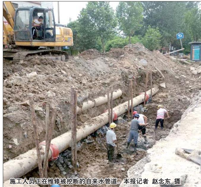
施工人员在维修被挖断的自来水管。本报记者 赵念东 摄
