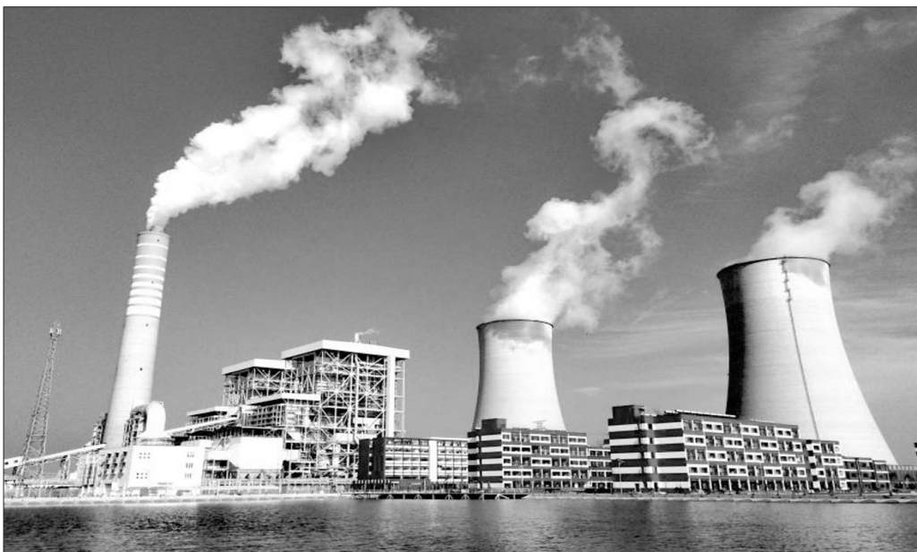
位于巴基斯坦拉合尔郊区的萨希瓦尔燃煤电站,由华能山东发电有限公司和山东如意科技集团共同建设。
