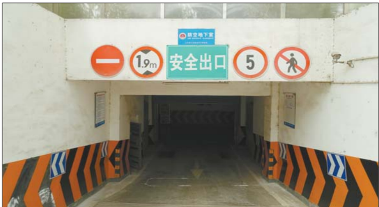
楼体下是防空地下室,让电梯井改造成了“死扣”。
