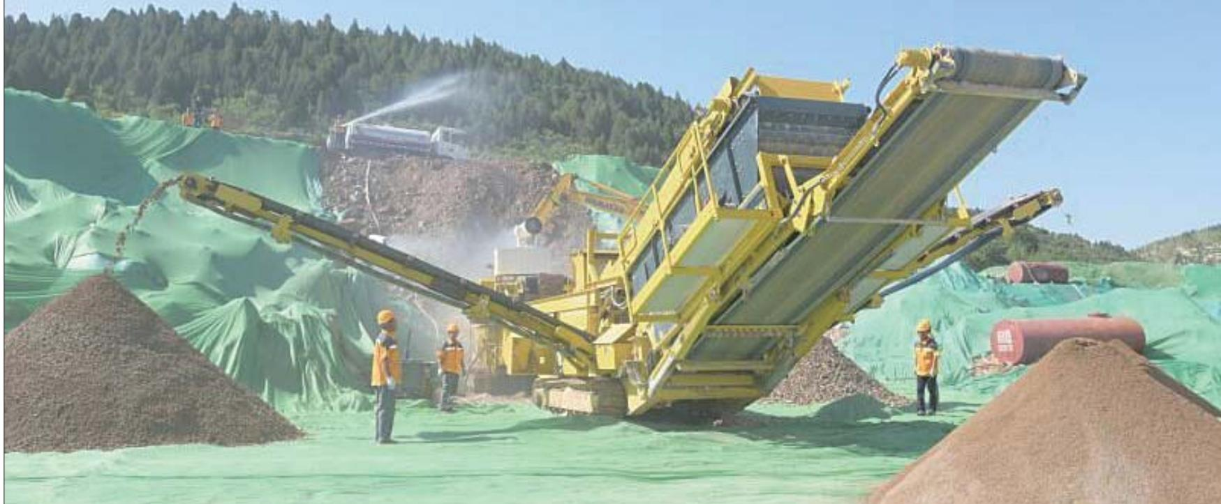
汉峪片区一工地,移动式破碎机将建筑垃圾重新加工制成空心砖。
