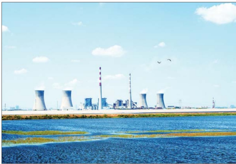
胜利发电厂全面完成超低排放改造。 通讯员 孙育涛 摄
