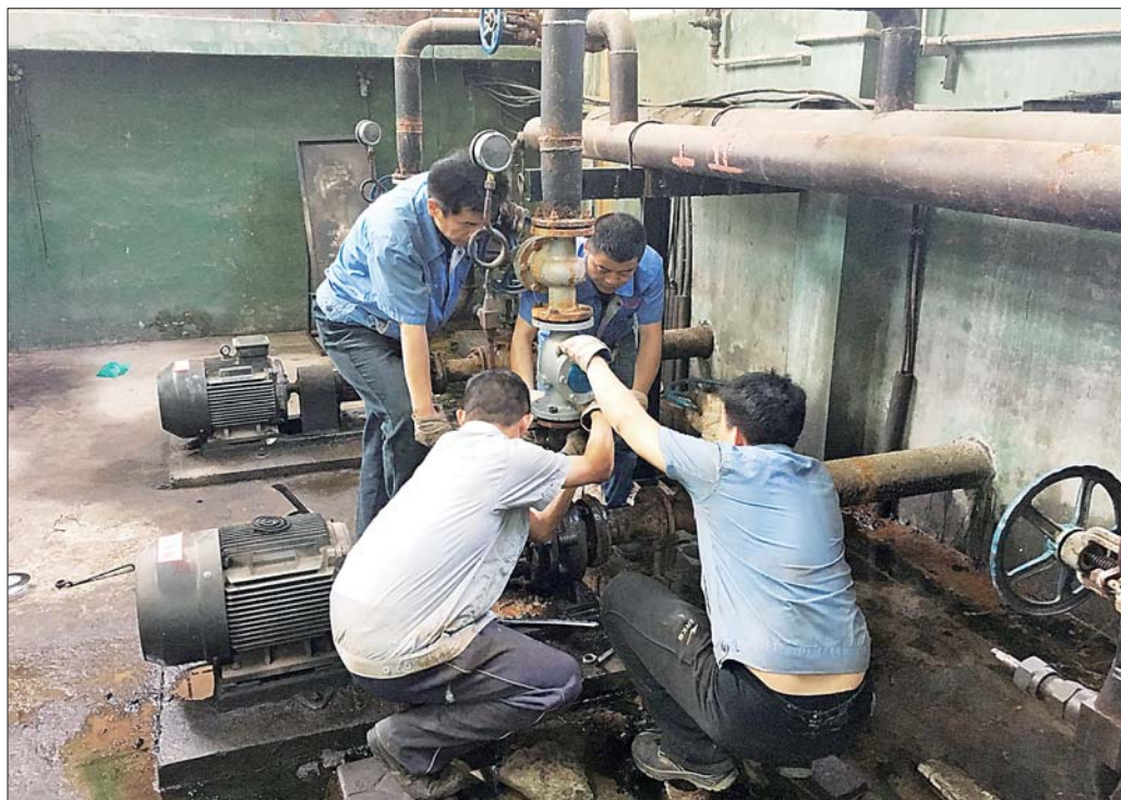
汽化车间工人正在检修设备。 本报记者 张帅 摄
