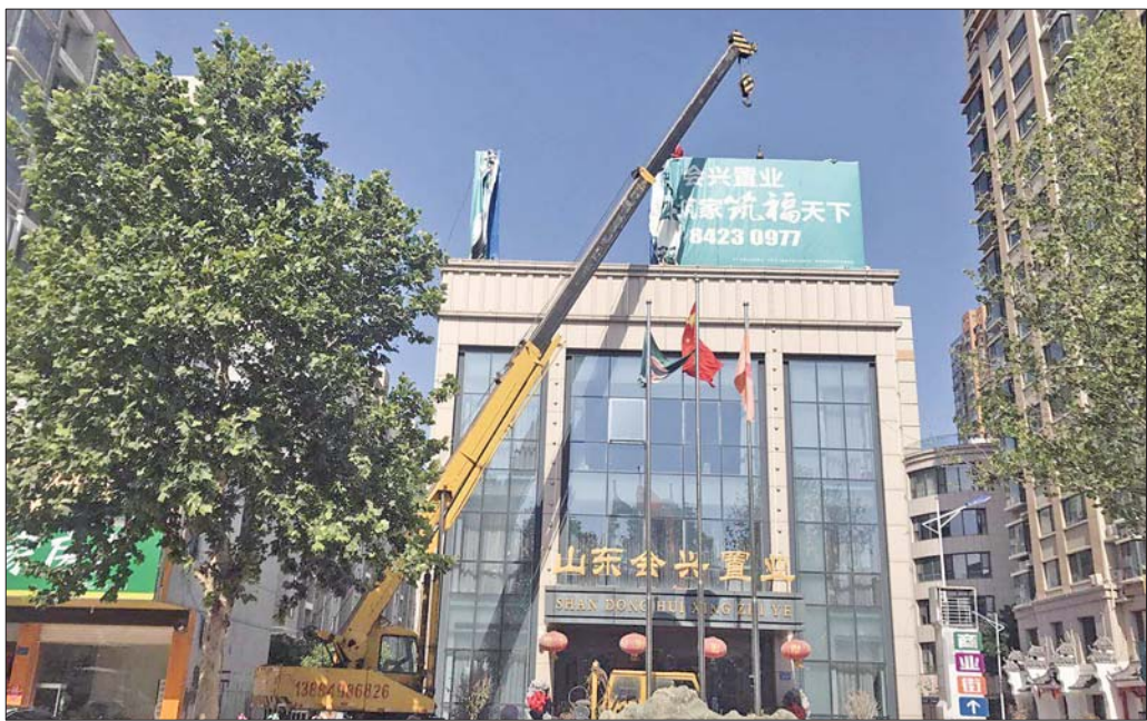
户外广告拆除现场。
