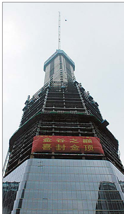
最后一斗混凝土注入,八方觚封顶。 本报记者 修从涛 摄
