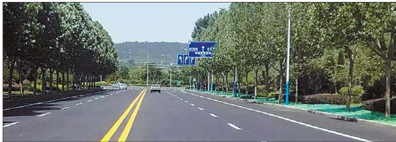
新铺设沥青道路19公里。
