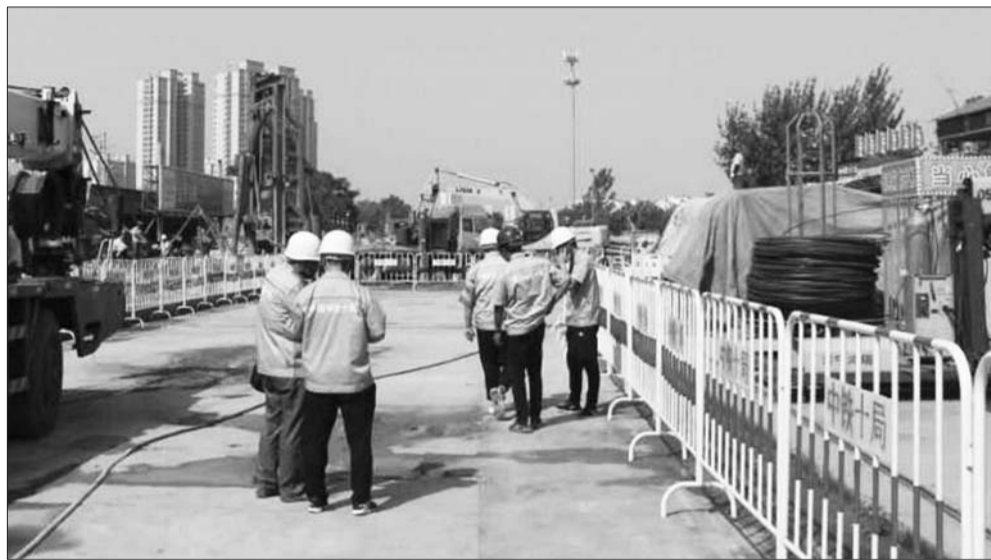
火炬路上跨新兖铁路立交桥上，一派繁忙景象。
