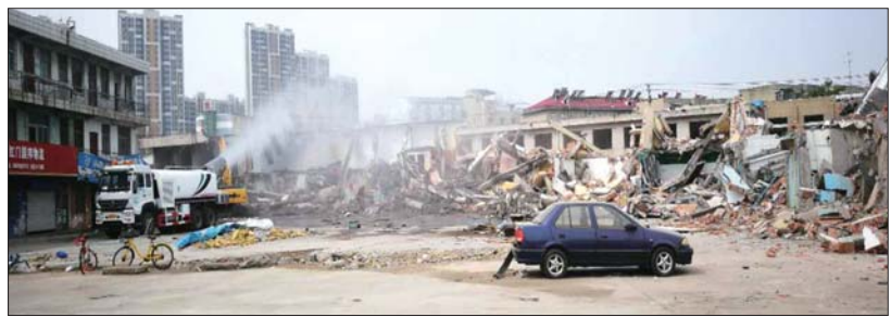
正在拆除中的全福汽配城违建。 本报记者 张阿凤 摄
