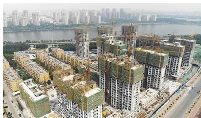
建设中的居民楼。
