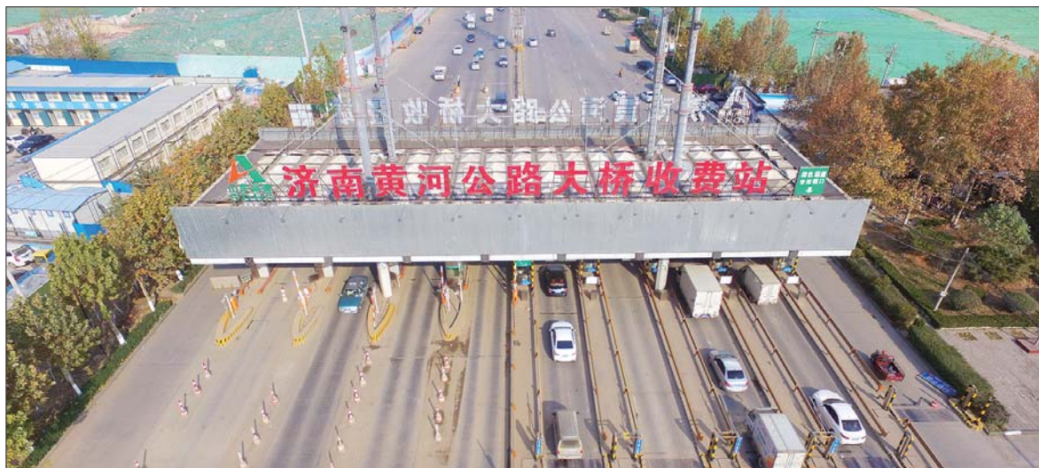
2017年11月中旬,济南黄河大桥收费年限到期,收费站拆除免费通行,而黄河北的物流企业盼望更多的跨黄通道对物流车辆减免费。(资料片) 本报记者 周青先 摄
