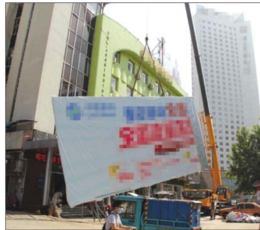
拆除现场。本报记者 侯海燕 摄
