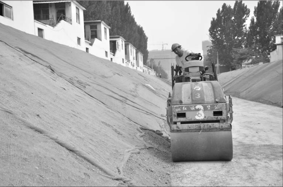
施工人员压实河床。 本报记者 孙璇 摄
