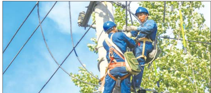
济南供电公司抢修人员正在抢修。本报记者 王皇 通讯员 张晓明 摄
