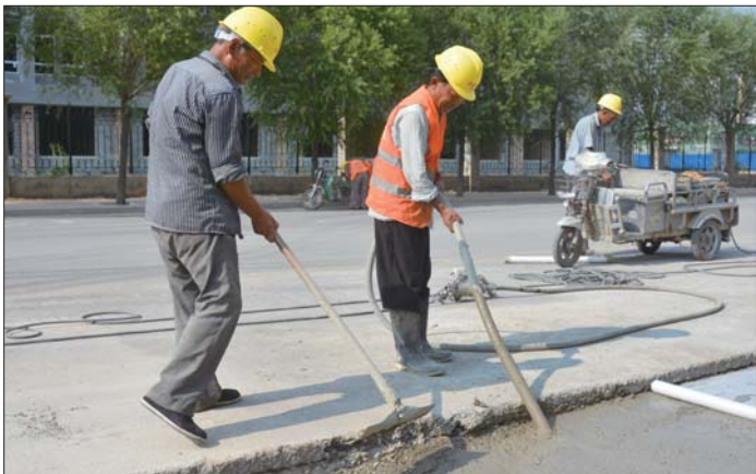
胡营社区南侧,供暖管网已经敷设完成,施工人员正在恢复路面。
