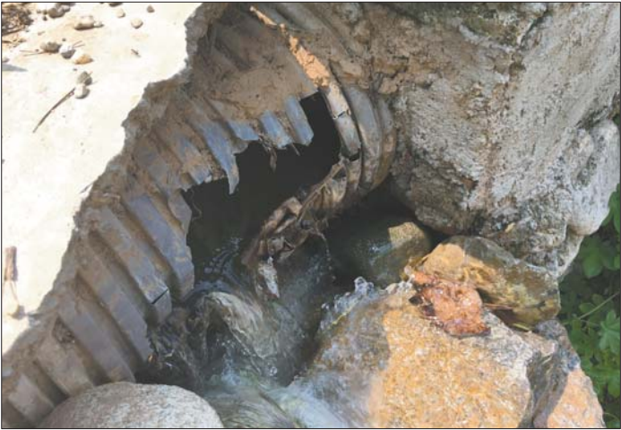
泉泸河西岸河堤，一处塑料污水管破损，污水泄入河内。
