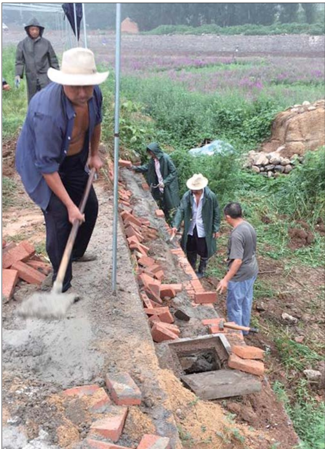
工作人员正在维修断裂的排污管道。 南山管委会供图
