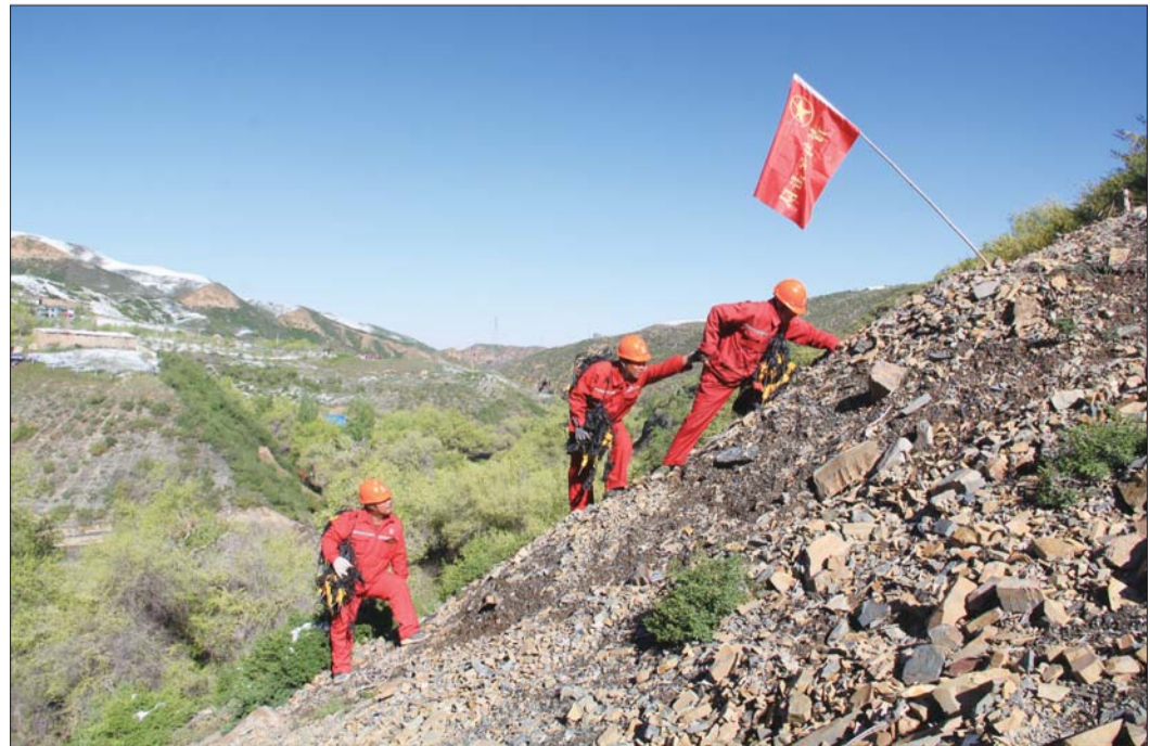
员工攀爬进入施工区域。
