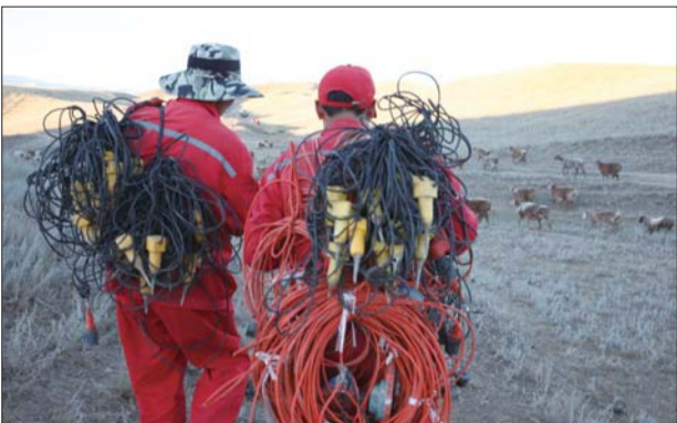
放线施工,一群羊经过。
