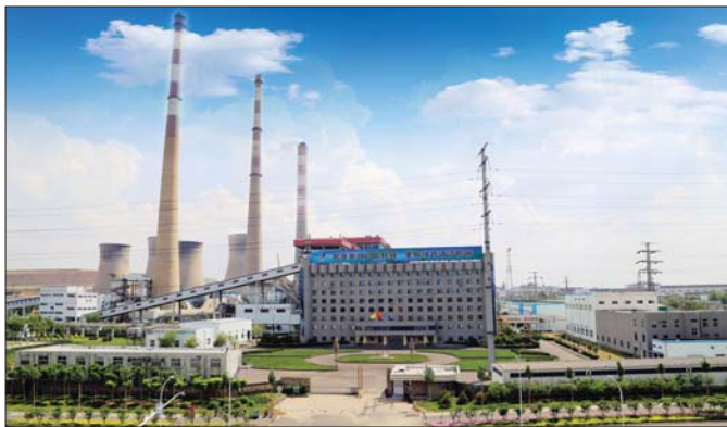
华电淄博热电有限公司办公楼。
