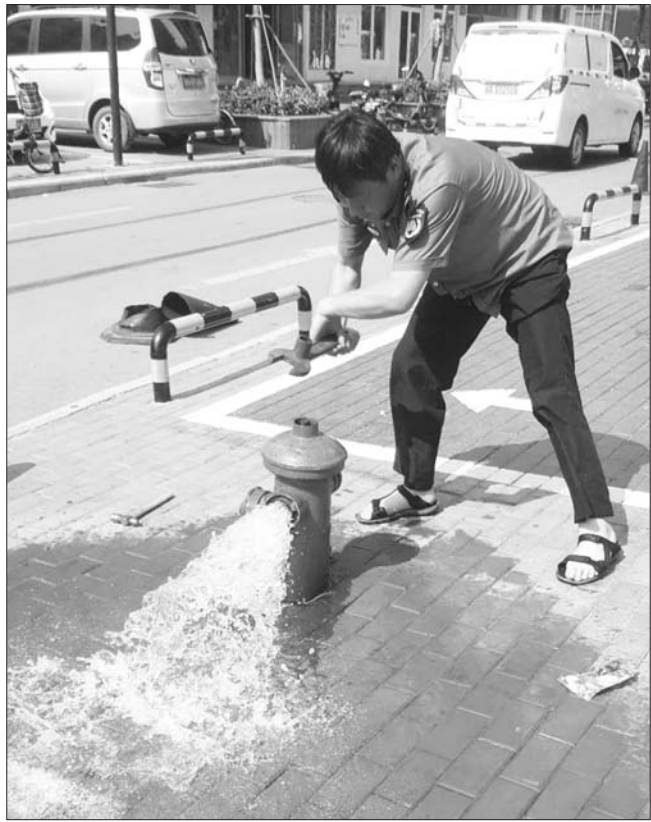
京杭佳苑消防栓水压正常。
