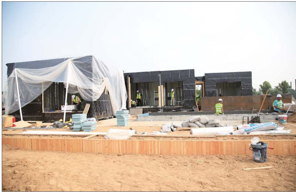
房屋的主体结构吊装完毕。
