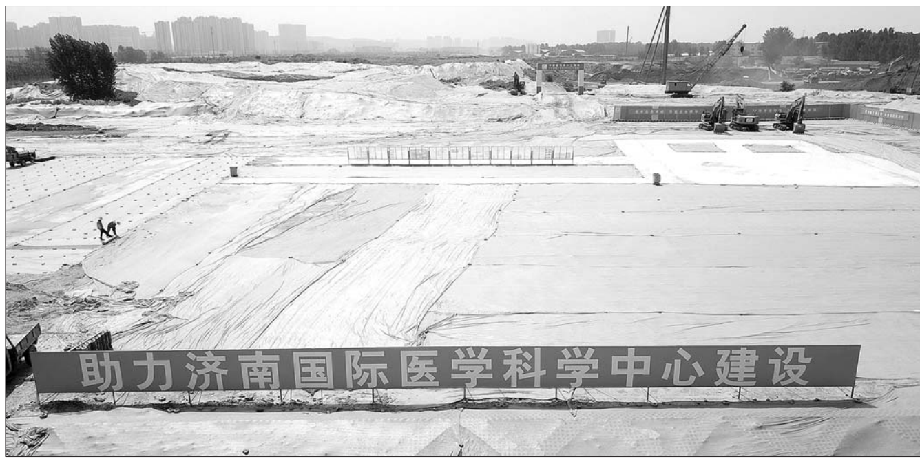
19日,济南西部刚刚开工的国际医学科学中心区域,部分工地上施工机械开始挖地基。 本报记者 周青先 摄
