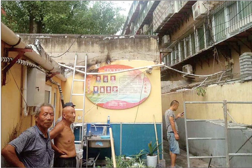
市中区舜玉小区违建拆除现场。 本报记者 张阿凤 摄
