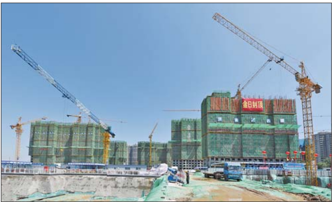
金海福苑施工现场。
