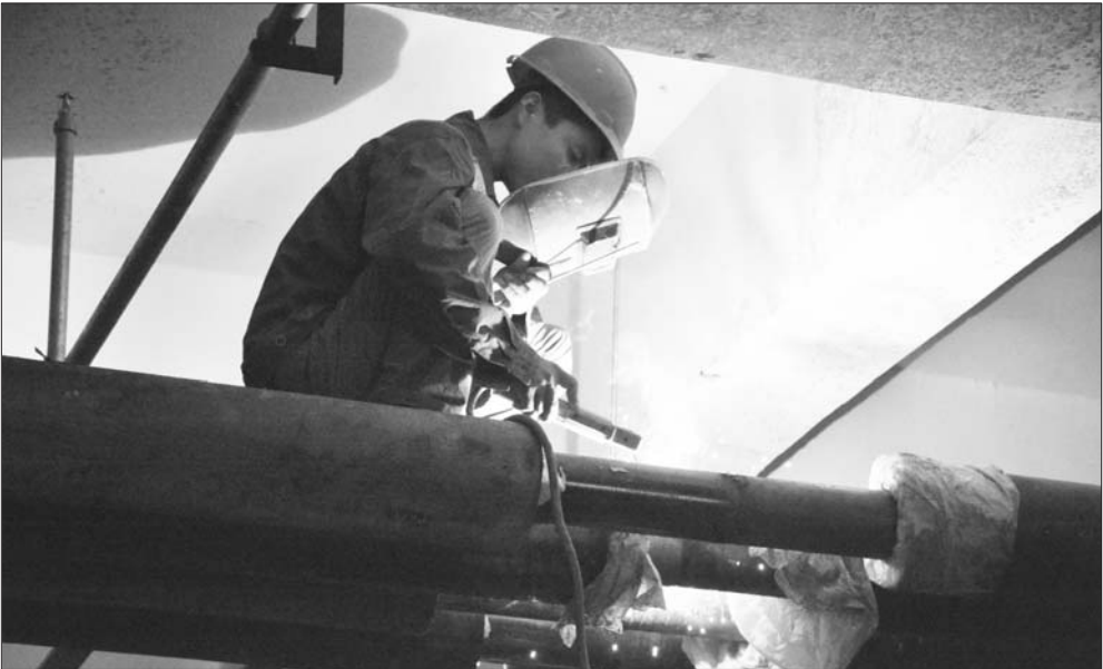
康城丽景供热管道敷设进入扫尾阶段。 本报记者 孙璇 摄
