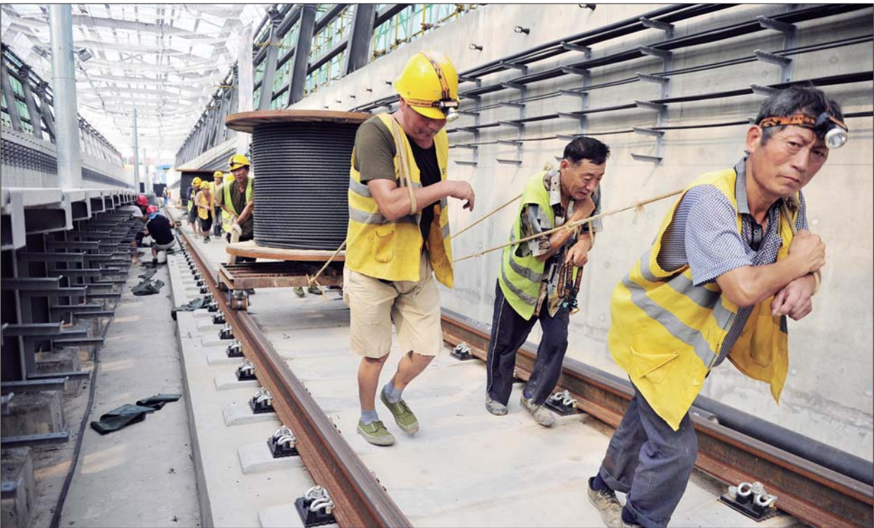
眼下，R1线已经全线轨通，施工工人们正在传送电缆，为下一步的电通做准备。 本报记者 王媛 摄
