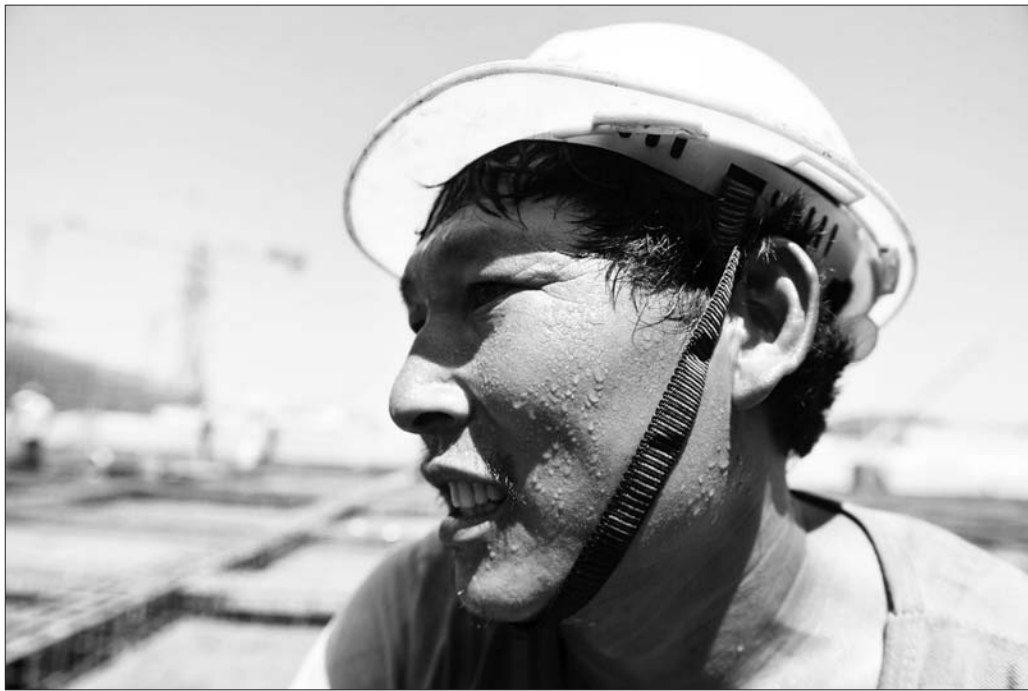
8月3日，在山东青岛火车西站建筑工地，一名工人在铺设钢筋。 新华社发
