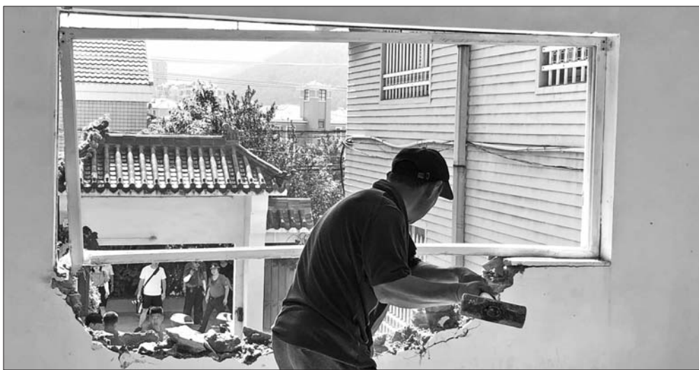
工人正在拆除违建小楼。
