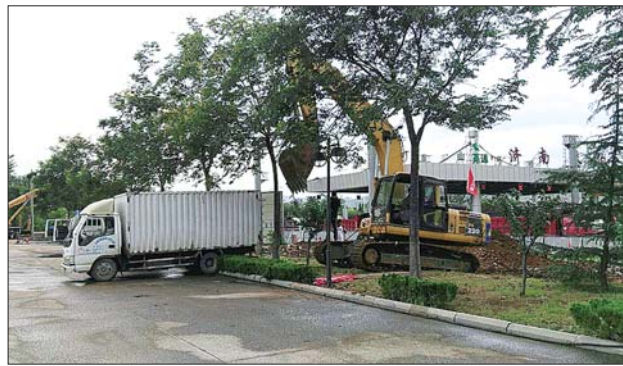
港沟收费站已启动拓宽改造工程。
