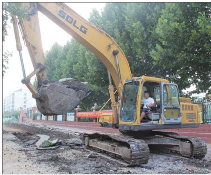
管道铺设施工现场。本报见习记者 邓超 摄
