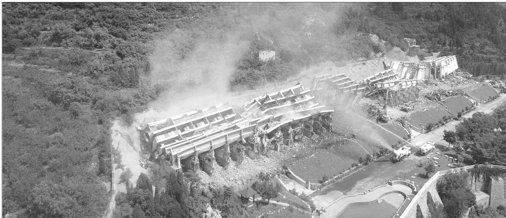
锦绣川水库北岸,济南最大单体违建九久红公寓全部倒塌。南山管委会供图
