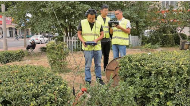
工作人员正在对自来水管进行“检漏”。
