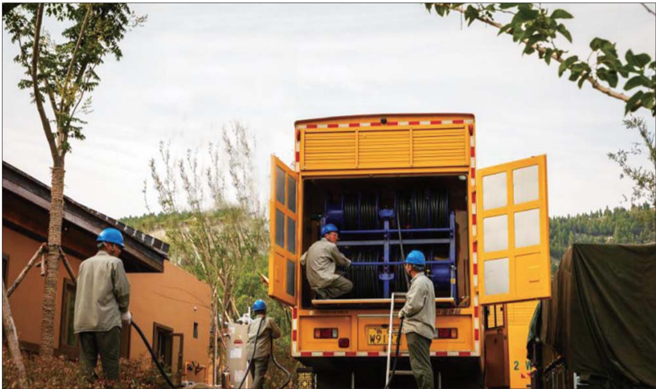
供电人员对应急电源车接线调试。 本报通讯员 王者东 摄
