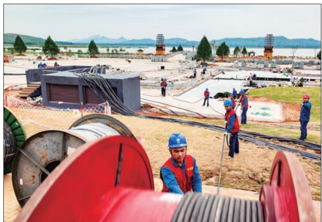
党员服务队成员敷设电缆。 本报通讯员 张萌星 摄
