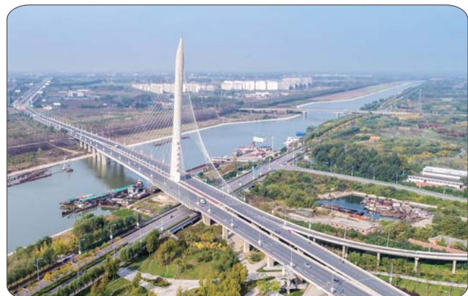
兴唐运河大桥。
