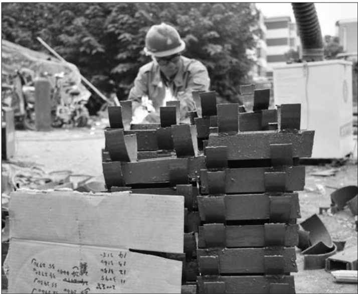
刘庄新村西区,施工人员正在焊接滑托。 本报记者 孙璇 摄
