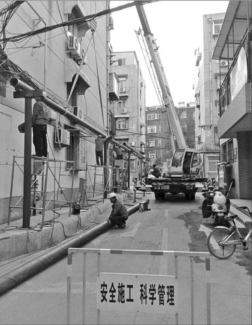
▲为了保证鲁艺小区居民用暖,工人正在进行二次管网施工。
