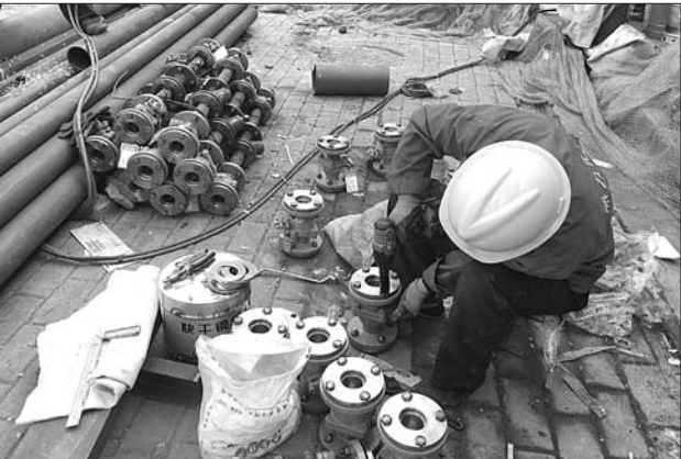
▲为了保证鲁艺小区居民用暖,工人正在进行二次管网施工。
