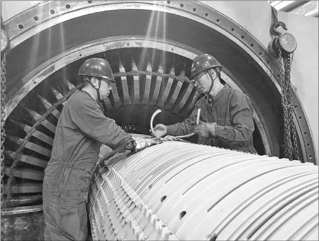
7号机组现场,工作人员在中心点周围做好起吊前保护措施。
