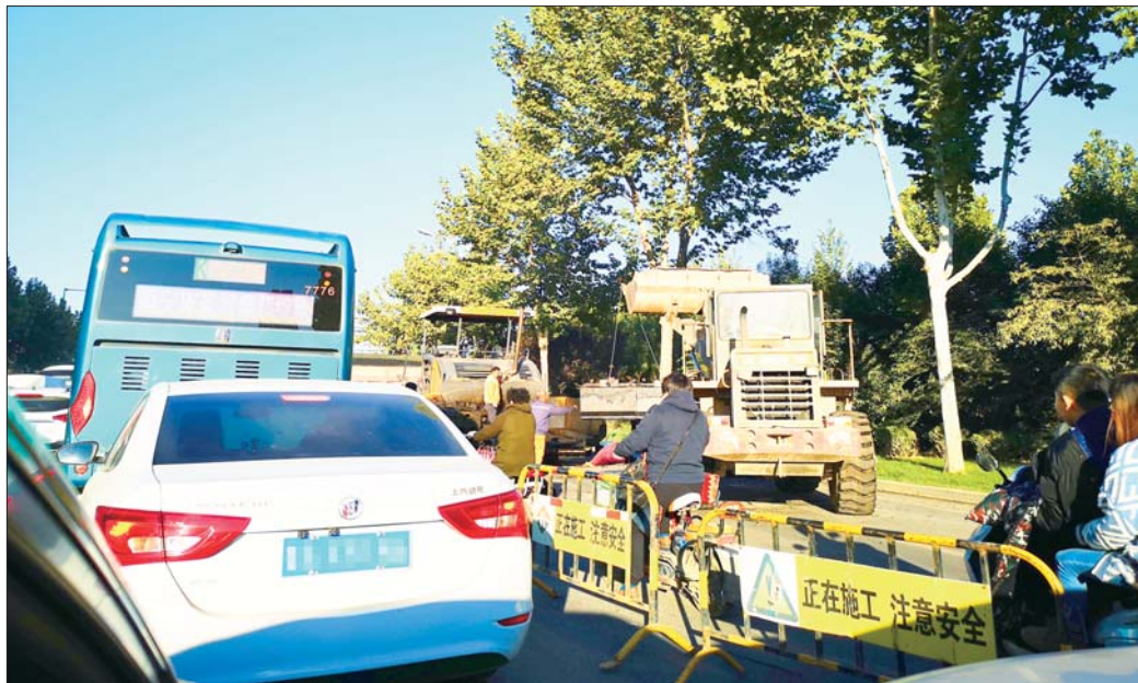
18日早7点多,因一小段路在铺沥青,还未到早高峰的世纪大道出现2公里拥堵。 本报记者 王皇 摄
