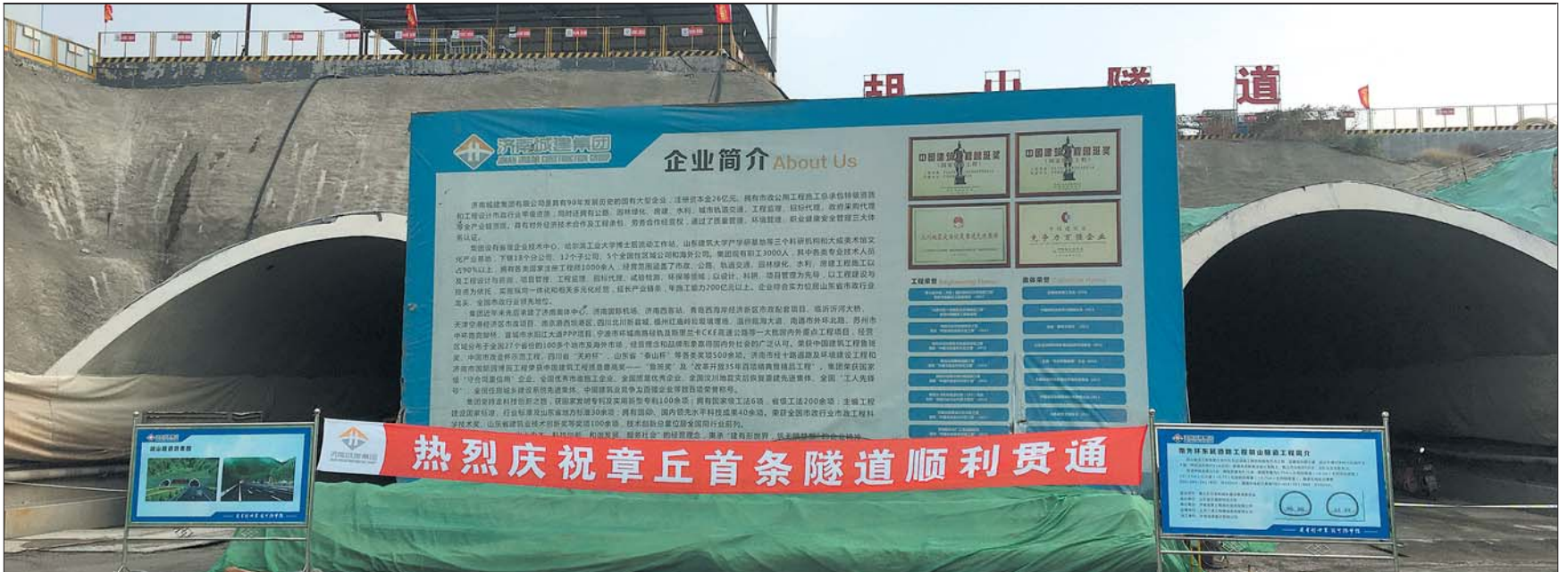
胡山隧道是章丘交通提升工程的重要组成部分。
