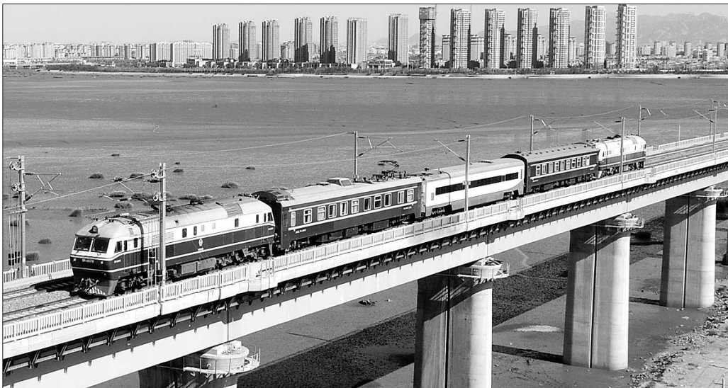
青连铁路检测列车驶过跨胶州湾特大桥。 本报通讯员 肖永顺 摄
