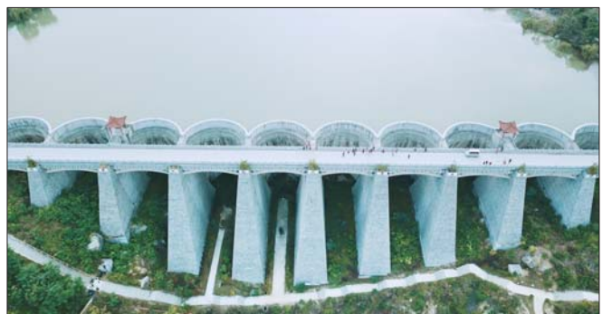
临朐九山镇淌水崖“斜卧式浆砌石十连拱大坝”被专家誉为“世界石砌连拱第一坝”。 本报记者 刘飞跃 摄
