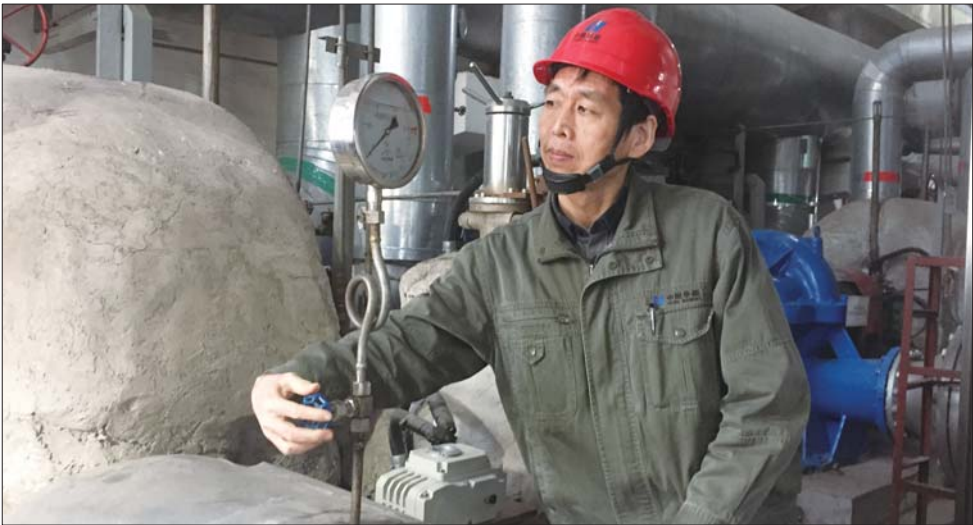
工作人员正在进行压力表调试。 本报记者 周惠娇 摄
