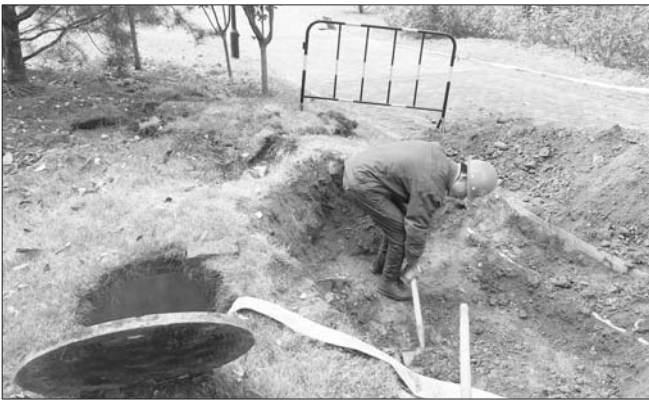
13日,济南历下区现代逸城小区内,供热公司维修人员正在寻找管道漏点。 本报记者 王杰 摄
