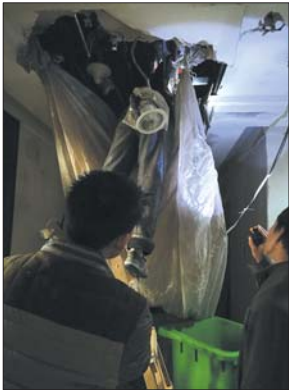
维修人员正在现场检修管道。 本报记者 戚云雷 摄
