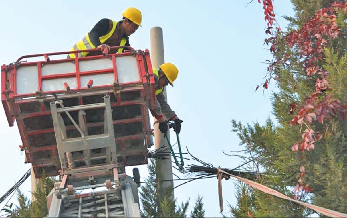
施工人员正在剪除“蜘蛛网”。 本报记者 张晓燕 摄
